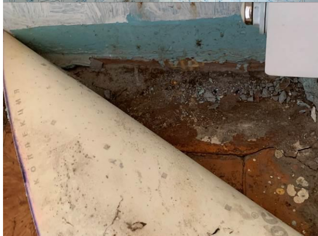
Видимые дефекты: затечные пятна, отставание обоев в помещении кухни
