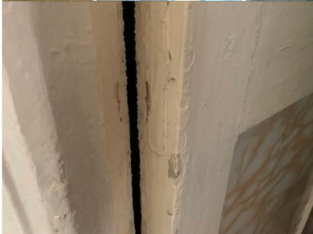
Видимые дефекты помещения коридора: затечные пятна на стенах и потолке, разбухание двери в помещение туалета, растрескивание краски
