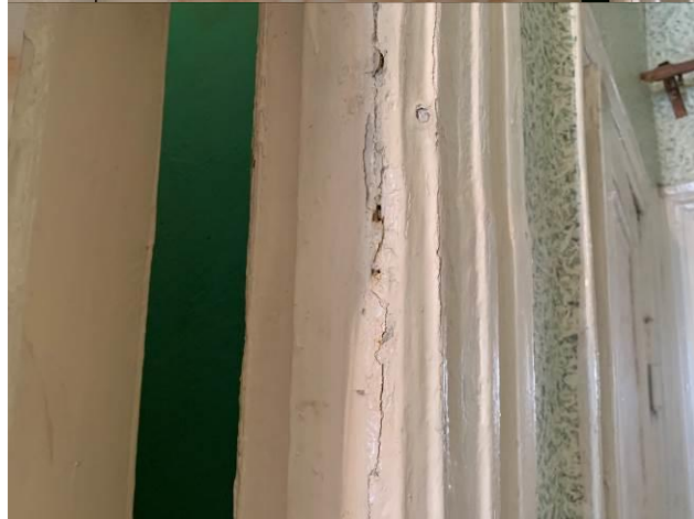
Видимые дефекты помещения коридора: затечные пятна на стенах и потолке, разбухание двери в помещение туалета, растрескивание краски
