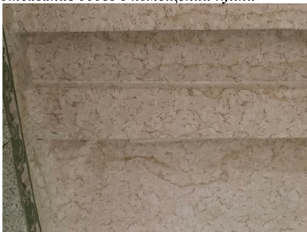
Видимые дефекты: затечные пятна, отставание обоев в помещении кухни
